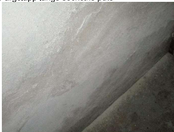
Fuktgenomslag längs yttervägg i matkällaren
