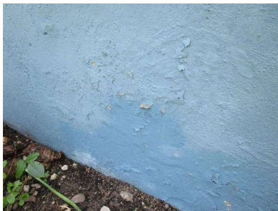
Färgsläpp längs sockelns puts
