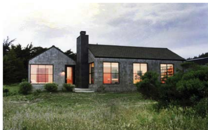
Referensobjekt, enplanshus, nockhöjd ca 4m. Naturligt grånat virke som fasadmateriäl, mörkt och diskret tak. Nick Noyes Architecture, Sea Ranch residens 2
