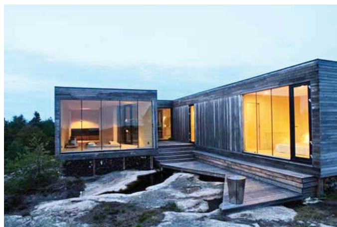
Referensobjekt Träbyggnad på plintar tar hänsyn till kalkberget
