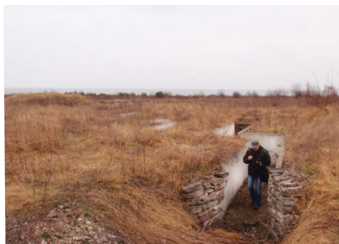
Nedgång i skyttevärn av betong
