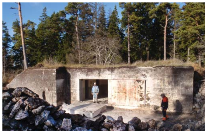
Friläggning och håltagning, byggnad nr 8
