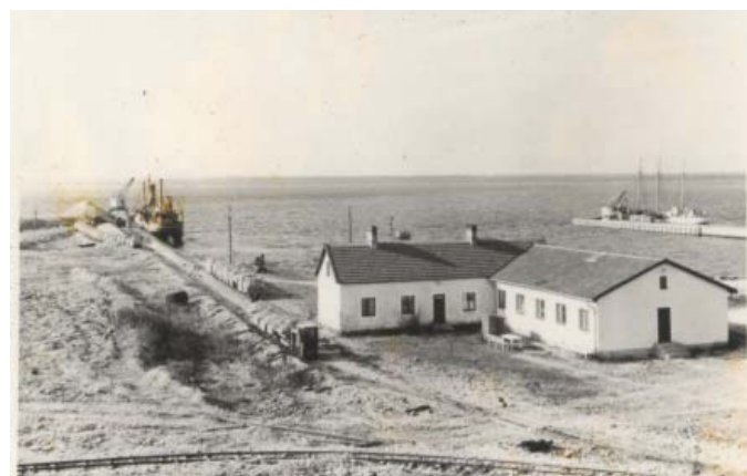
Arbetarbostäderna vid den yttre utlastningsbryggan. Den smalare delen är äldre från ca 1910 och den bredare tillbyggnaden från ca 1944
