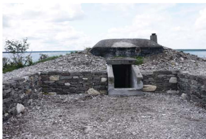
Befintligt värn 22:40, "Vargen" integrerat med den nya gården. Stenmuren är nylagd med Bungenäskalksten. Beläggning av befintligt utsorterat grus från urgrävningen.
