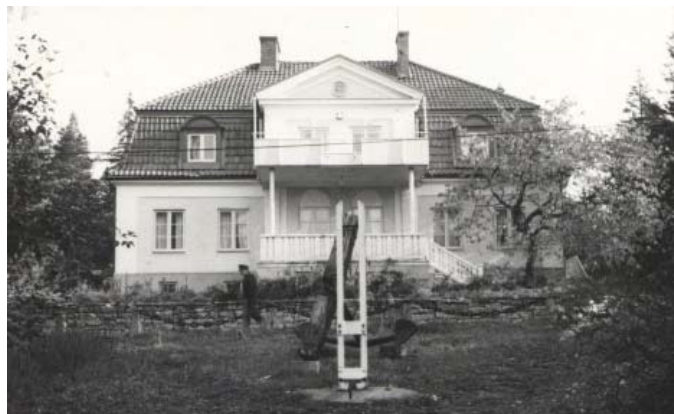
Förvaltarvillan med påbyggd balkong ca 1940-tal
