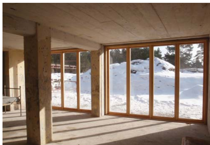
Den tidigare slutna byggnaden har numer glaspartier mot söder och den nedsänkta gården.
