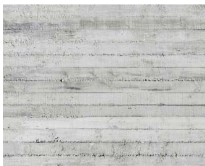
Omålad betong, gjuten mot brädform
