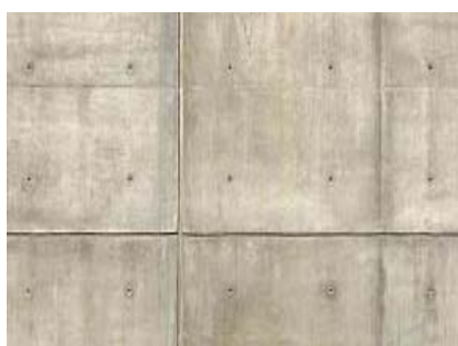
Omålad betong, gjuten mot skivform
