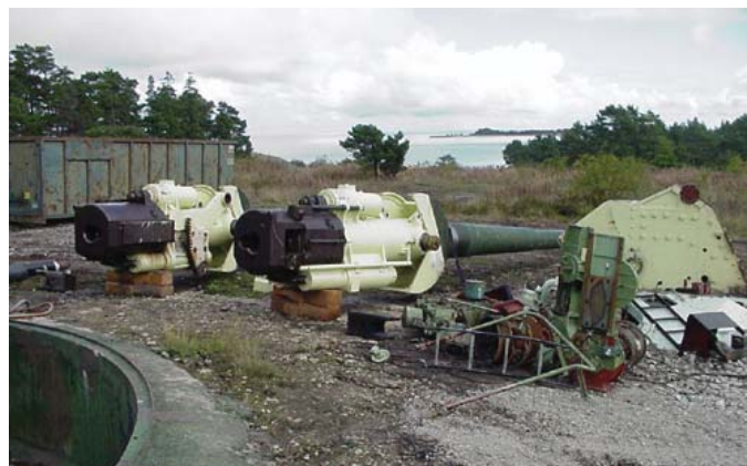
Nedmontering av pjäsvärn (byggnad 104)
