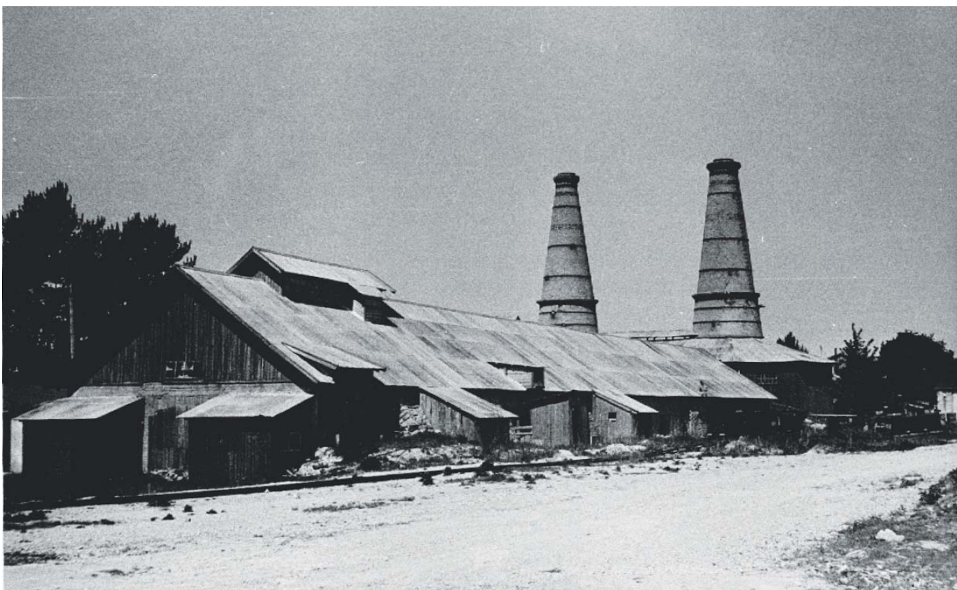
Kalkladan och de kringbyggda ugnarna.
