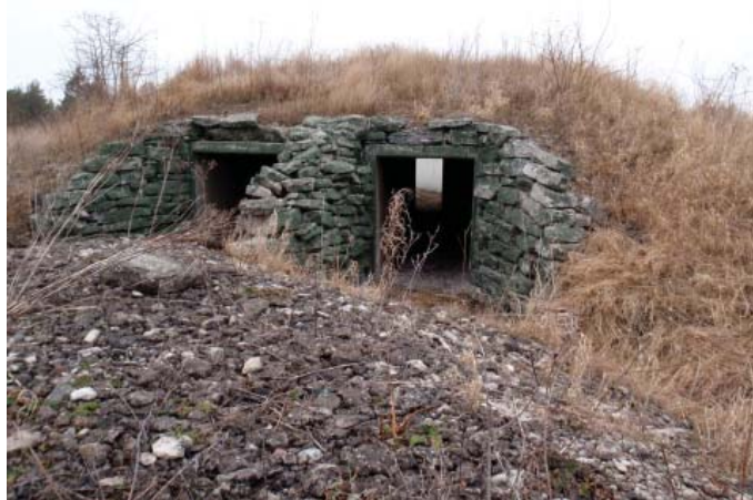
Befintlig ingång till bunker, kamouflagemålad kalksten
