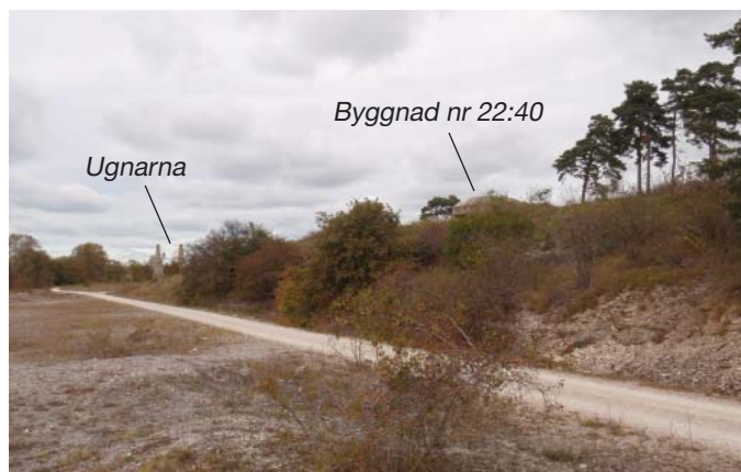
Befintligt värn nr 22:40, foto taget från vägen, endast främre delen av bunkern synlig. Nybyggnad helt dold från vägen.
