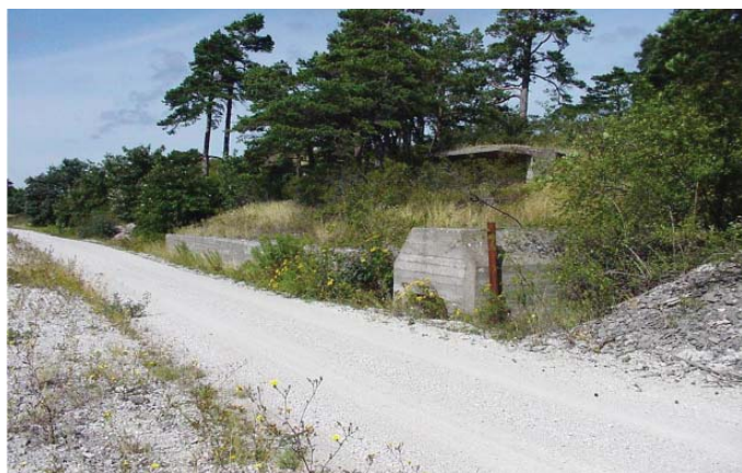
Bunker, byggnad nr 65 och vägspärren nedanför Sahara
