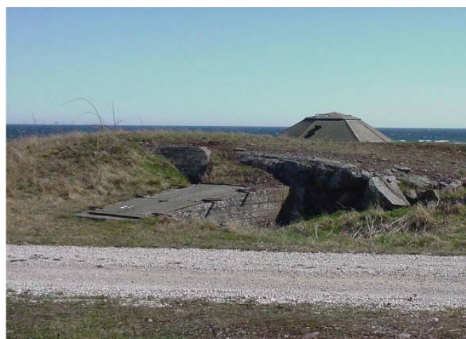
Befintlig byggnad nr 62 straxt nedanför vägen
