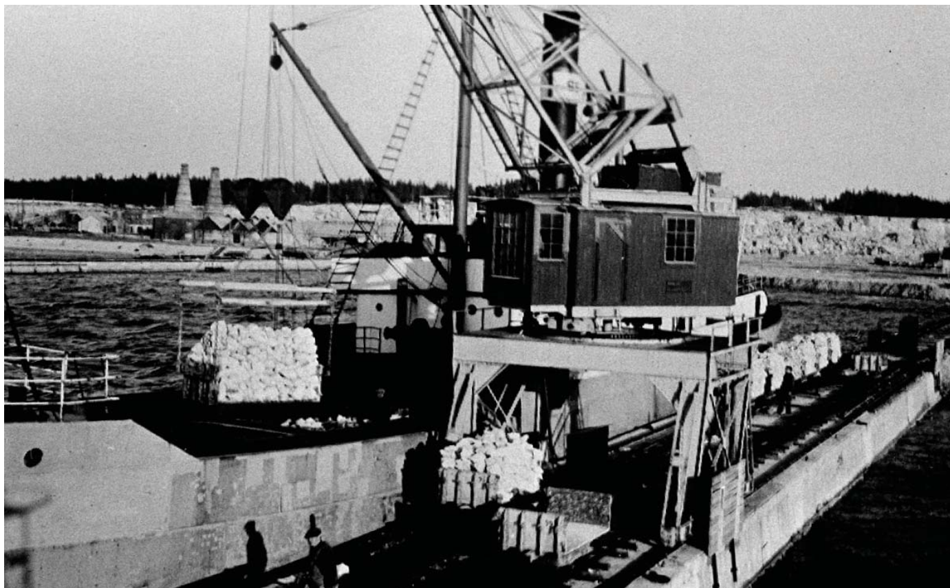
Modern elektrifierad kranlastning 1929, "tredje bryggan"
