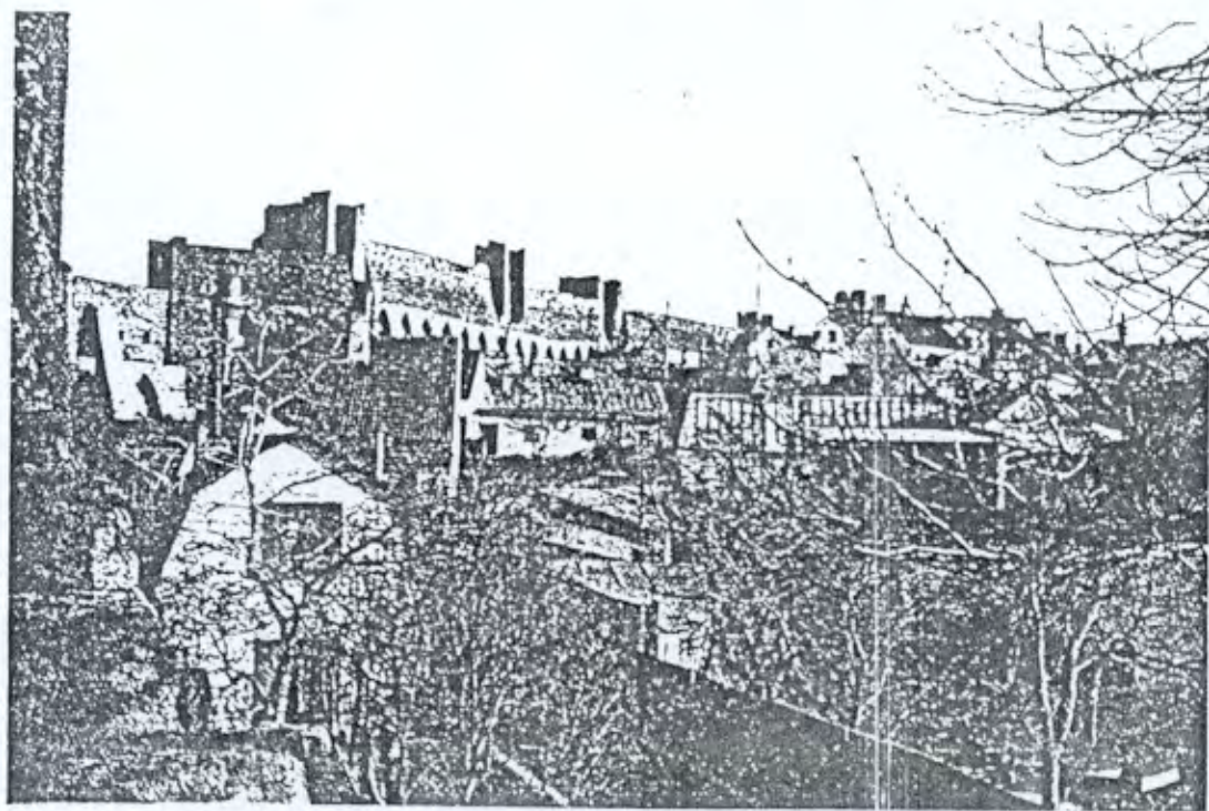
ÖSTRA RINGMUREN FRÅN INSIDAN.
