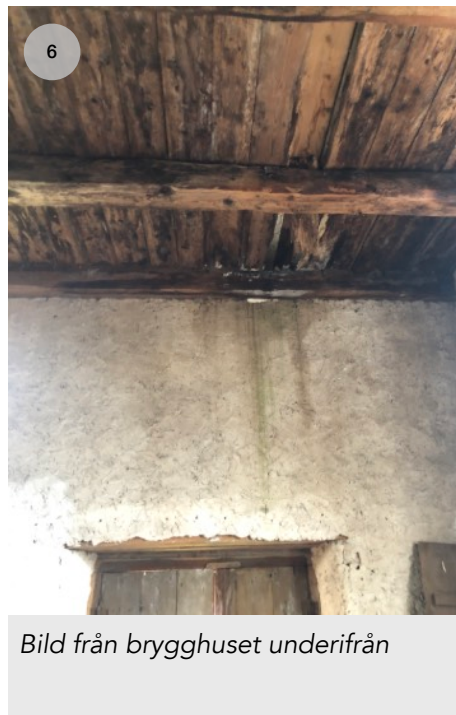
Vattenskada i kammaren, till följd av vattenläckage i taket
