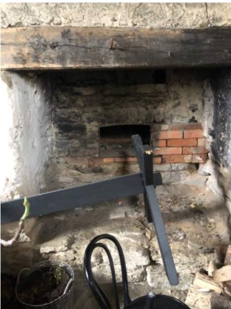
En av bakugnarna. Muren utvändigt behöver fogas.
