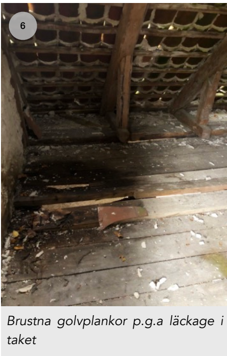
Vattenskada i kammaren, till följd av vattenläckage i taket
